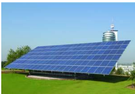
Hinter dem Werk 3 steht die Nachführanlage SunCarrier mit 30kWp Foto: KACO GERÄTETECHNIK GmbH
