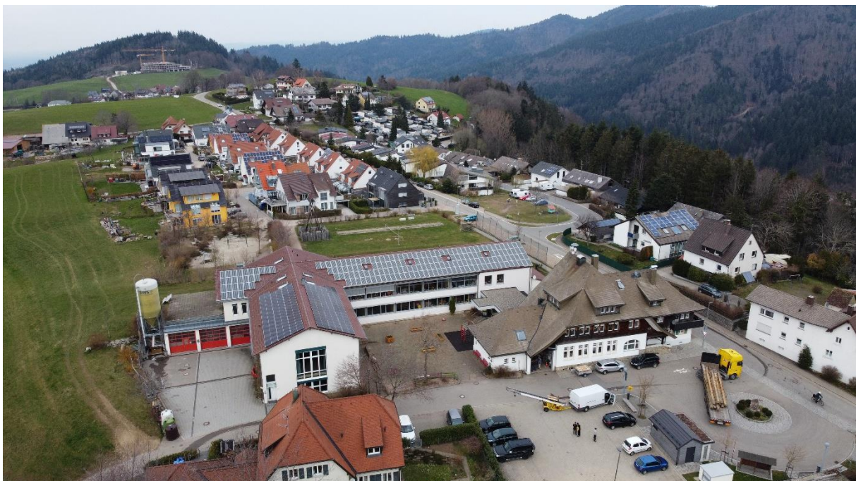
Abbildung 9: Luftaufnahme der Grundschule der Gemeinde Horben mit der nach Süden ausgerichteten, zu Projektbeginn bereits bestehenden PV-Anlage (auf dem langen Gebäude) und der nach Ost-West ausgerichteten neuen PV-Anlage (höheres Gebäude, auf dem Foto im Vordergrund) Bildquelle: Gemeinde Horben
