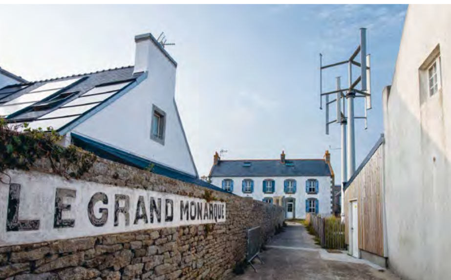
Die Windrädchen der EDF, windgeschützt platziert mitten in dem kleinen Dörfchen auf der ansonsten windreichen Île de Sein.
