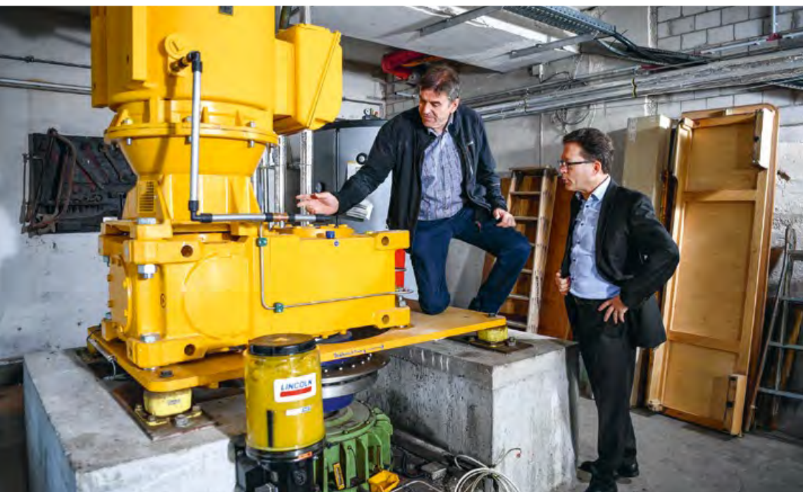
Bernd Spielmann (links) und Thomas Puchan überprüfen die neue Turbinensteuerung.
