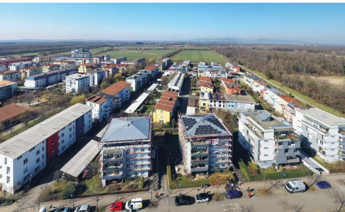
Freiburg-Rieselfeld: Auf zwei Dächern im Vordergrund entstehen PV-Anlagen – auf den anderen ist noch viel Platz dafür. * Foto: Bernd Kulow
