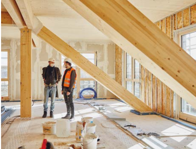
Markus Lager und Projektleiter Markus Willeke (re.) im zweiten Geschoss. In den Bürozone sind offene, loftartige Arbeitsbereiche geplant – mit Zugang zur Dachterrasse.
