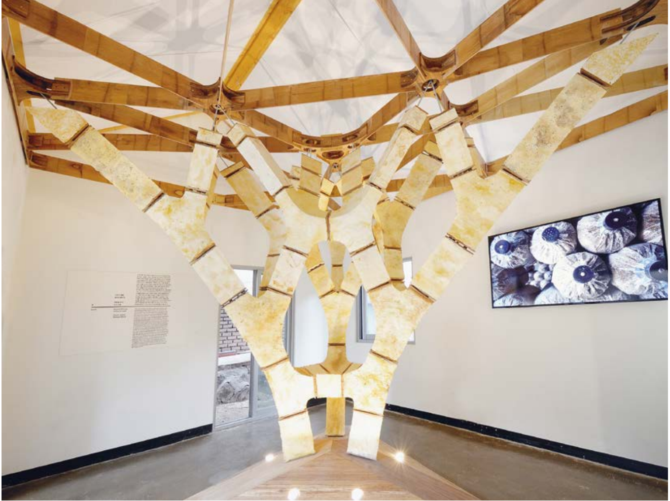
Pilz-Steine als Baumaterial: Der «Mycotree» von Dirk Hebel und seinem Team wurde 2017 auf der «Seoul Biennale of Architecture and Urbanism» ausgestellt. Die tragende Konstruktion aus unter anderem Pilz und Bambus veranschaulicht, dass auch ohne Verbundstoffe wie Beton effektiv und sicher gebaut werden kann. • Foto: ETH Zürich / Silk and Salt Images
