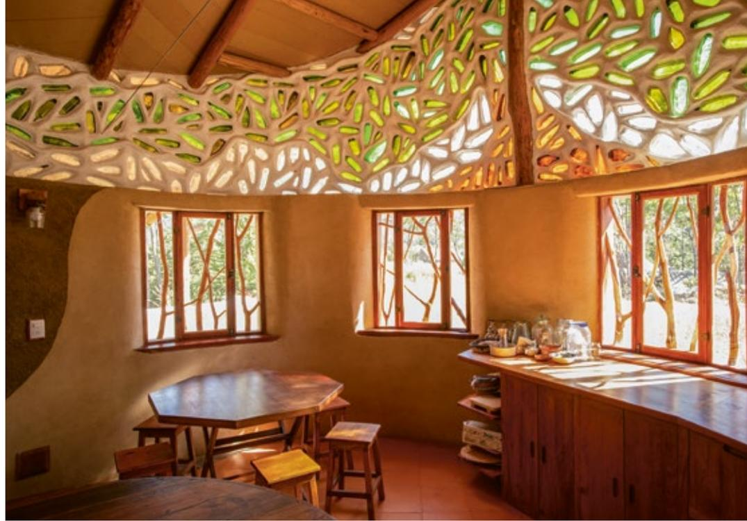
Oft integriert die Architektin Glasflaschen in ihre Lehmkonstruktionen. Sie schaffen eine angenehme indirekte Beleuchtung und lassen das Licht wie durch Glasmalerei farbenfroh schimmern.
