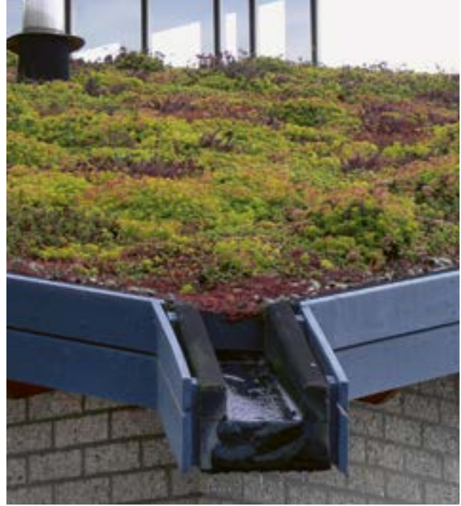
Begrünte Dächer speichern Wasser und mindern so den Abfluss – durch Verdunstung kühlen sie zudem die Umgebung. Foto: Lamiot / Wikimedia Commons
