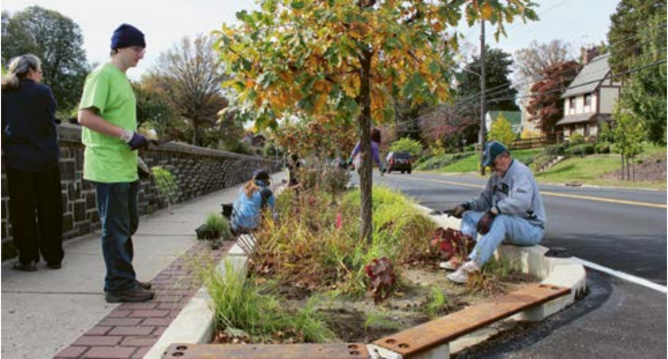
Gemeinschaftliches Pilotprojekt in Philadelphia, USA: Im Zuge des «Green City, Clean Waters»-Programms helfen Anwohner bei der Bepflanzung von Versickerungsflächen. * Foto: Verwendung mit freundlicher Genehmigung des «Philadelphia Water Department»
