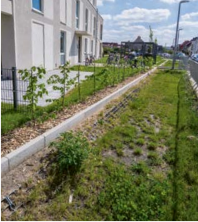
Bei Starkregen nehmen Versickerungsmulden zunächst große Mengen an Wasser auf, ehe es kontrolliert im Boden versickert. Foto: Andreas FranzXaver Süß / Berliner Regenwasseragentur
