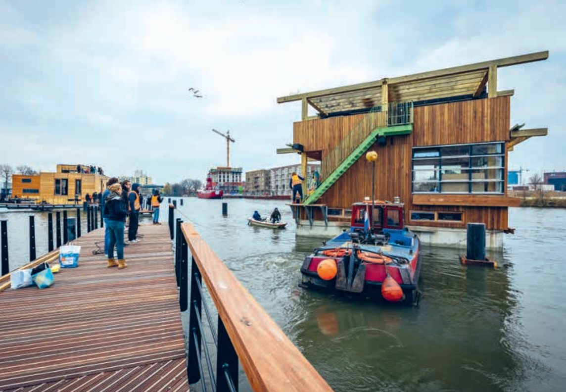
Die meisten Häuser wurden in einem nur wenige Kilometer entfernten Gewerbegebiet auf den Betonschwimmkörpern errichtet und dann an ihre endgültigen Liegeplätze geschleppt. * Foto: Isabel Nabuurs
