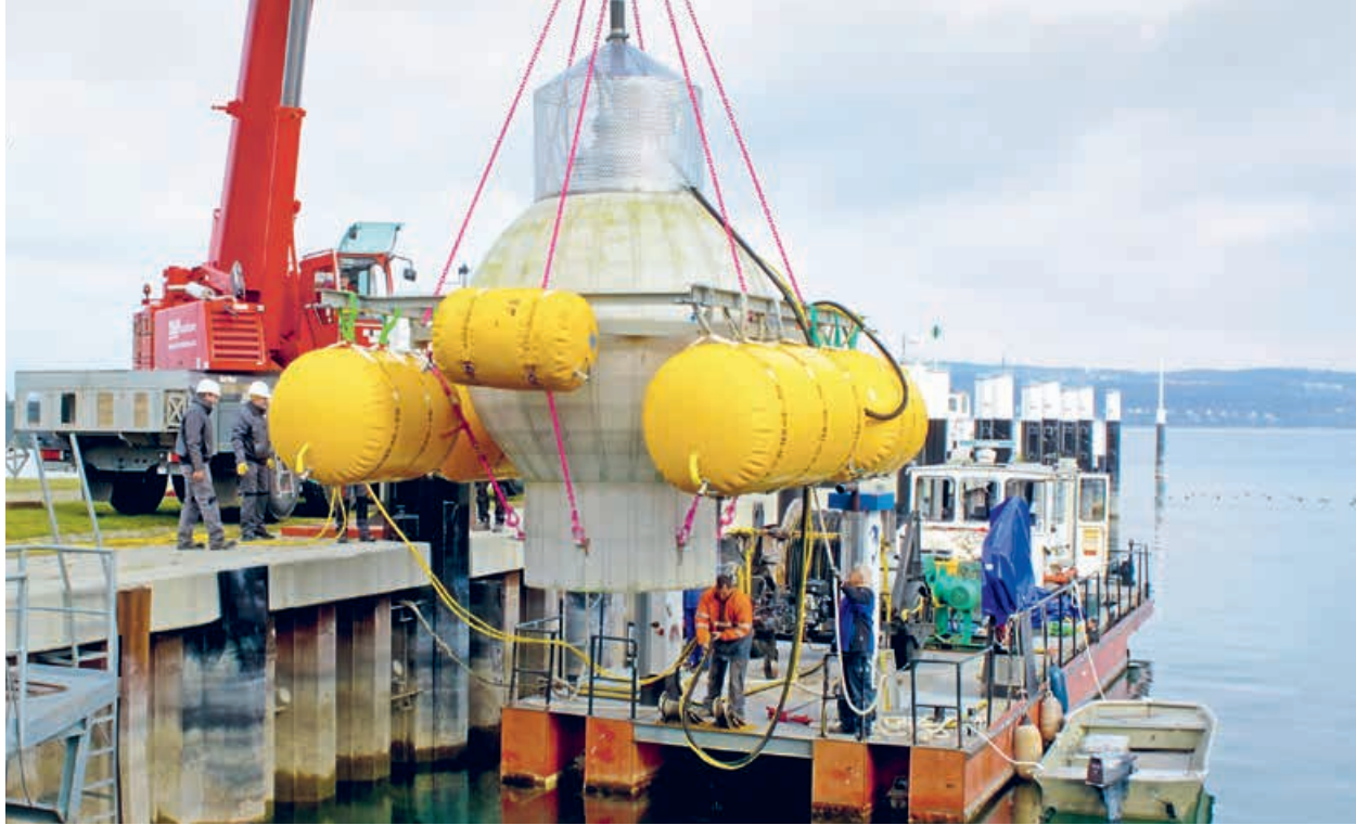
Test im Bodensee: Die 20 Tonnen schwere, hohle Betonkugel mit drei Meter Durchmesser wird in 100 Meter Wassertiefe versenkt. Bei Stromüberschuss wird die Kugel leer gepumpt, bei Strombedarf mit Wasser geflutet. • Foto: Fraunhofer IEE
