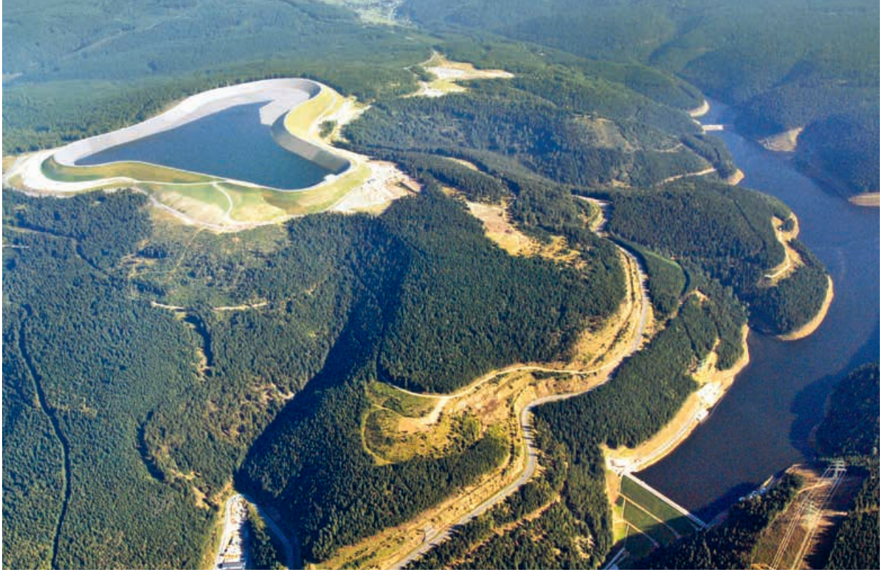
Deutschlands größtes Pumpspeicherkraftwerk in Goldisthal: Bei Stromüberschuss befördern Pumpen Wasser nach oben und nehmen dabei bis zu 1.160 Megawatt aus dem Netz auf. Herrscht Strombedarf, erzeugen die Turbinen bis zu 1.060 Megawatt. Foto: Stefan Thomas / picture alliance
