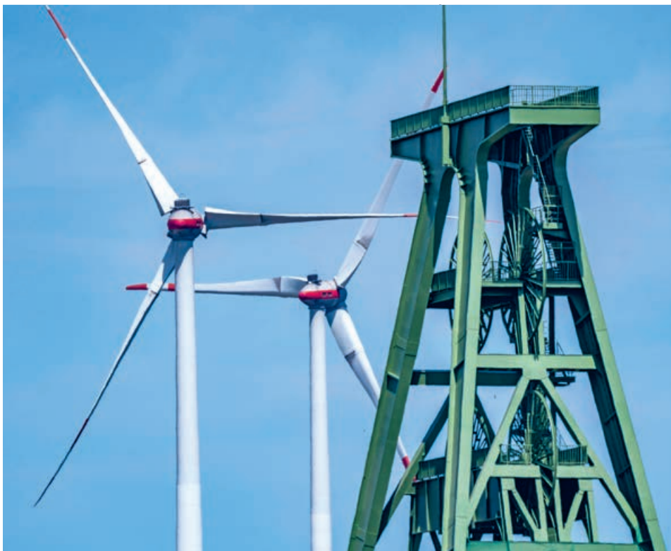
Ein alter Bergwerkschacht als Speicher? Nach dem Prinzip des Schwerkraftspeichers wird Sand in die Tiefe gelassen und mit überschüssiger Energie wieder emporgefördert – und bei Bedarf vice versa. Hier die ehemalige Zeche Lohberg in Dinslaken. * Foto: Jochen Tack / Imago
