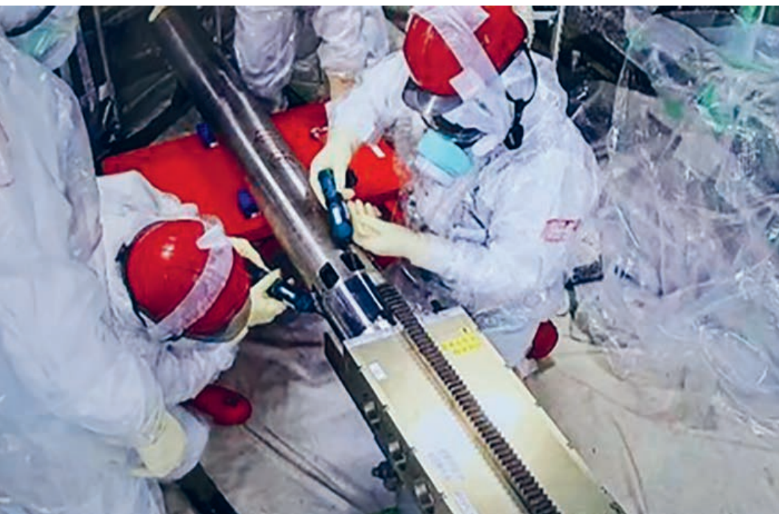
Letzte Vorbereitungen für die Bergung einer Probe des geschmolzenen Brennstoffs am 10. September 2024. • Foto: Tokyo Electric Power Company Holdings / picture alliance
