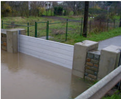
Hochwasserschutz vor einer Einfahrt
