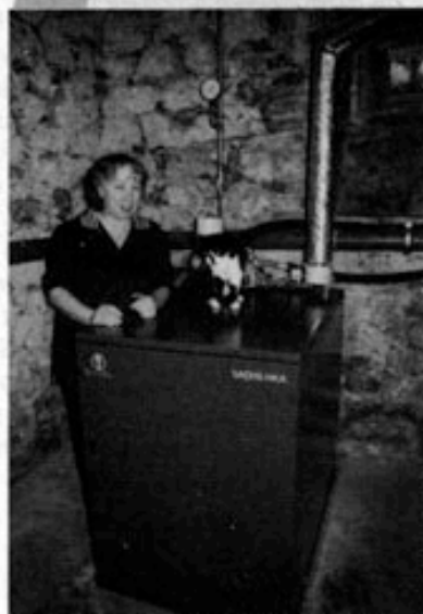
Energiesparen auch im eigenen Keller: Ursula Sladek mit Blockheizkraftwerk
